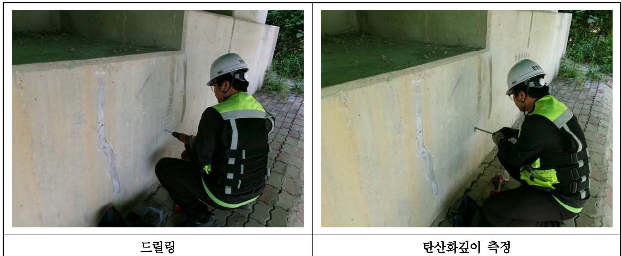
【사진 37.4.3】 탄산화 깊이 측정 현장사진
