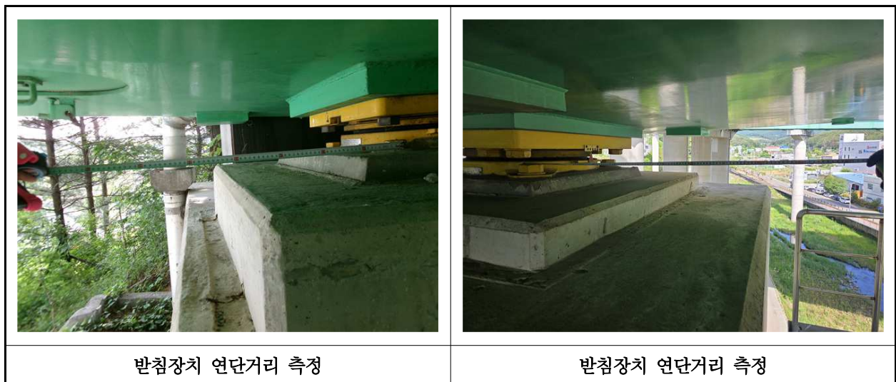
【사진 37.3.15】 교량받침장치 연단거리측정
