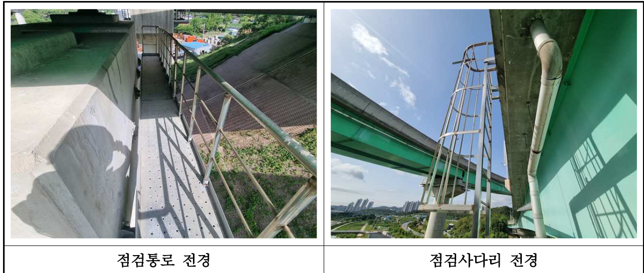
【사진 37.3.26】 교량 점검시설 전경
