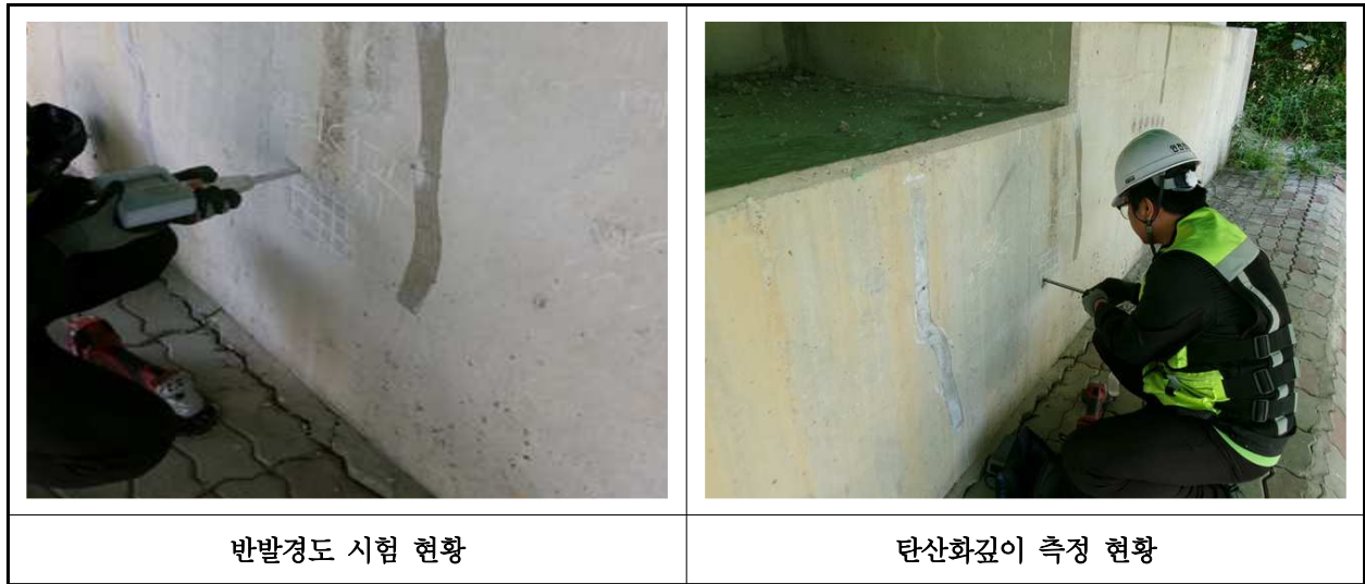
【사진 37.4.1】 콘크리트 내구성조사 현황
