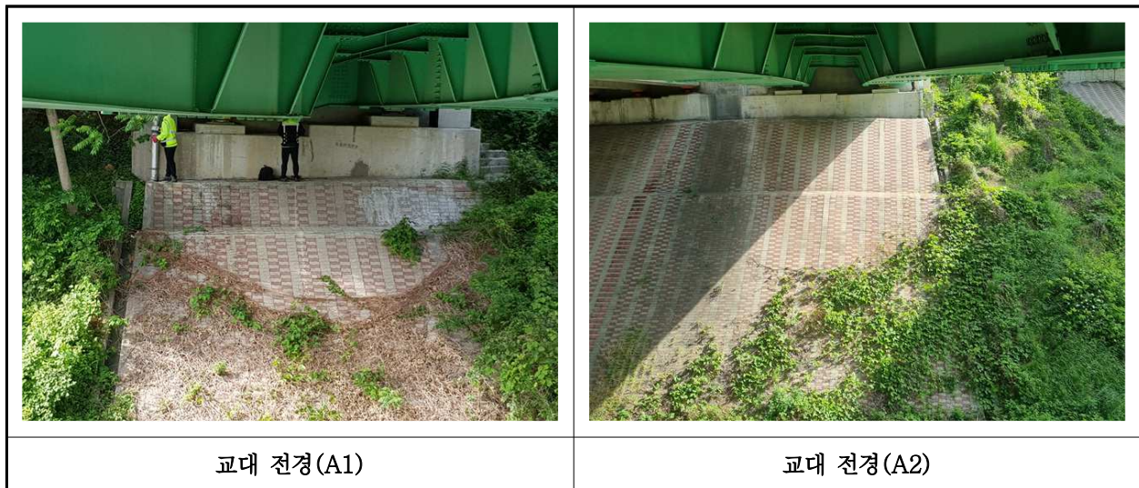
【사진 37.3.8】 교대 전경
