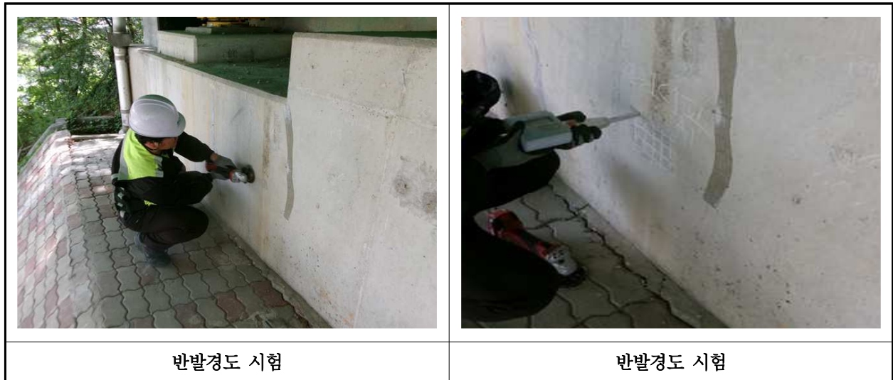
【사진 37.4.2】 반발경도시험 현장사진
