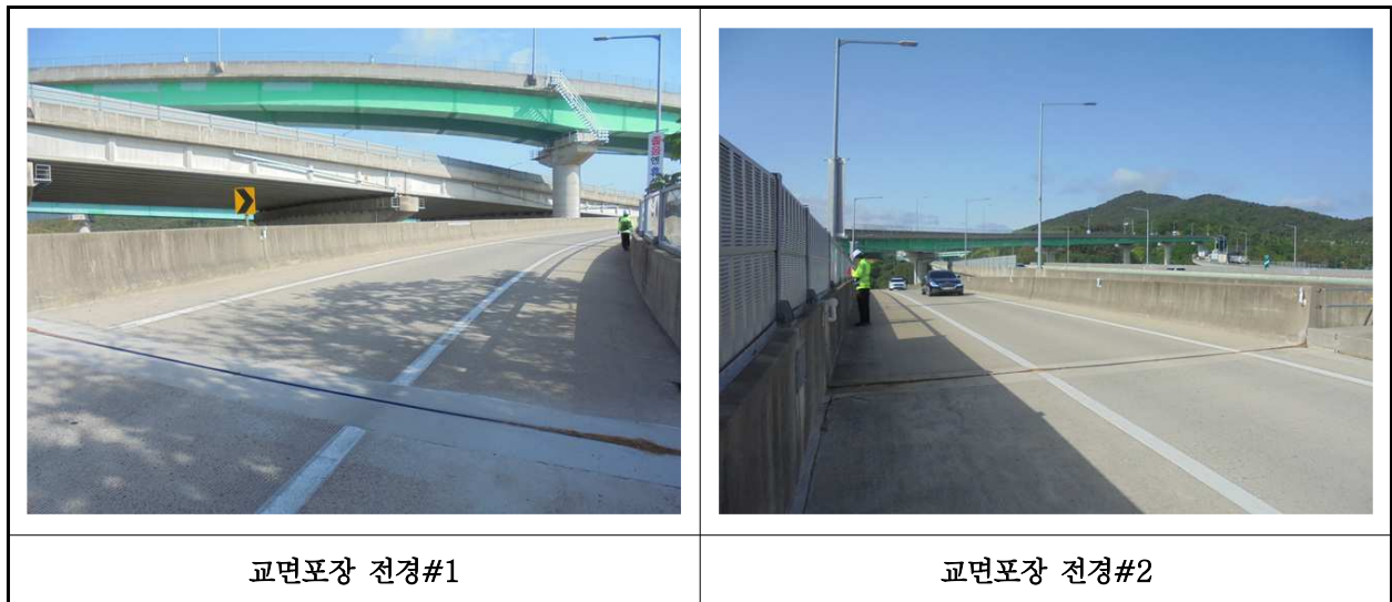
【사진 37.3.20】 교면포장 전경
