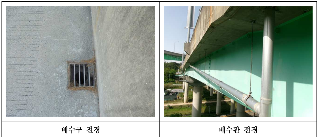
【사진 37.3.22】 배수시설 전경
