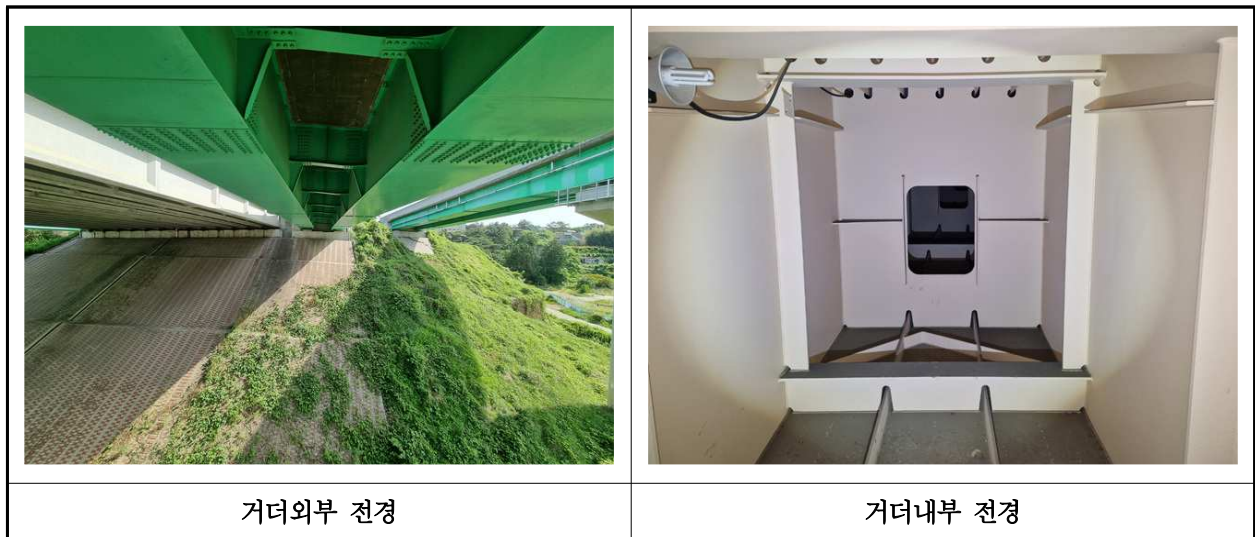
【사진 37.3.4】 거더 전경
